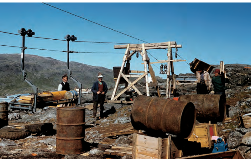
Qillerinermi atortut assartorsinnaajumallugit silaannakkut amoortaammik pilersitsinissaq pisariaqarsimavoq. 1958-imi qillerinertigut Kuannersuarni uraneqassuseq misissorneqarpoq.
