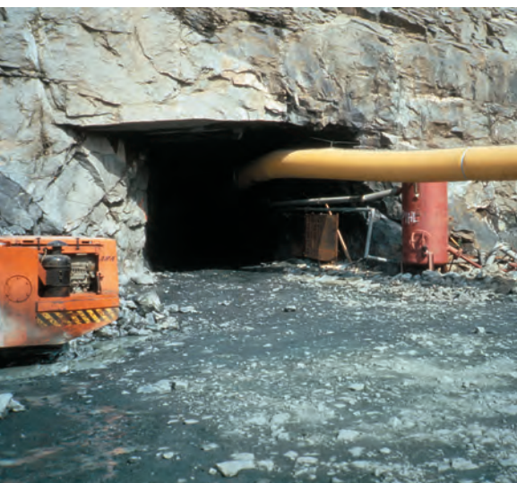
Kuannersuarni 1978-imi misissueqqittoqarmat qaarususuk 960 miiterisut takitigisoq qaartiterneqarpoq, taanna aqputigalugu akuiaqassaq 20 000 ton aaneqarluni. Silaannarissaatit sakkortuut aatsitassasiorfimmiit radonip aniatinneqarnissaanik qulakkeerisut, ruujoritut sungaartutut takuneqarsinnaapput.
