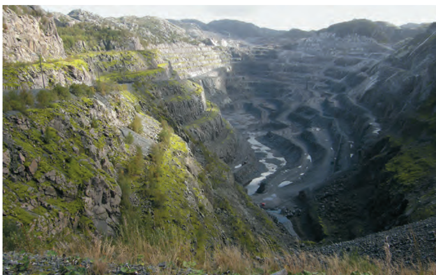
Eksempel på en åben mine med den karakteristiske spiralformede adgangsvej.
