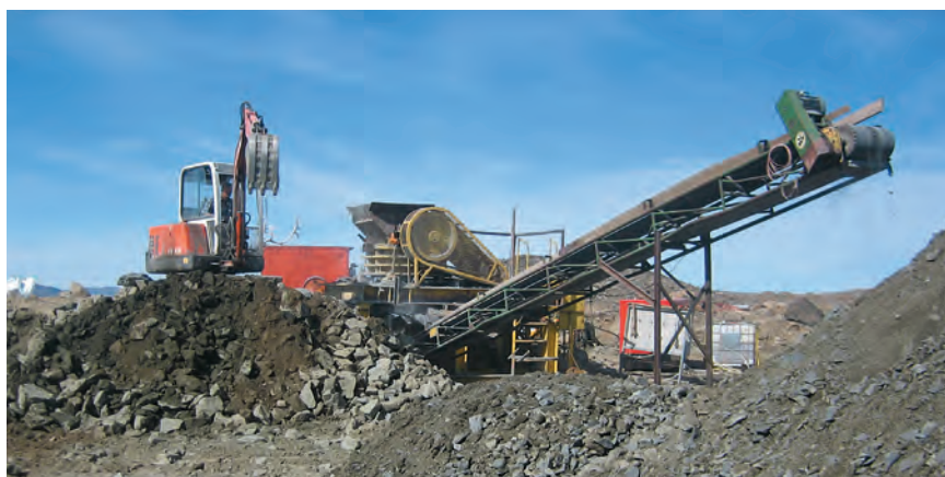
Råstofprojekt ved Kangerlussuaq. Et midlertidigt transportbånd er etableret til sortering af mulig malm fra et råstofprojekt.
