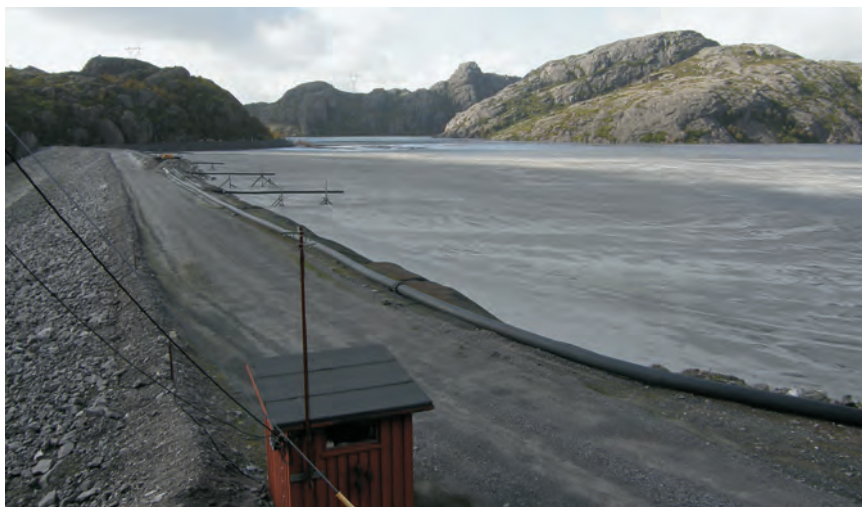
Eksempel på tailingsdeponi i forbindelse med Titania-minen i Syd Norge. Dæmningen bygges højere i takt med at tailingsniveauet stiger.
