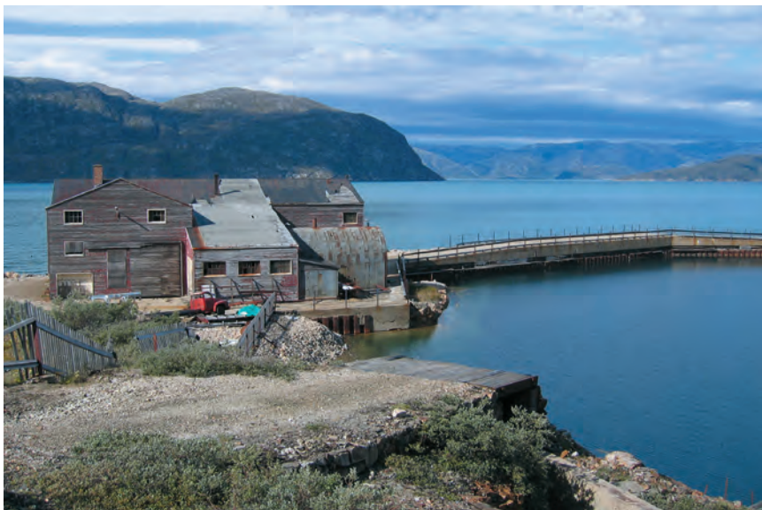
Kryolitbruddet ved Ivittuut i Sydvestgrønland, 2010. Bruddet var oprindeligt afskærmet mod fjorden af en dæmning og holdtes tørt ved en konstant udpumpning af indsivende vand. Efter lukningen i 1987 trængte vandet gradvist ind, og hullet er nu helt fyldt op med vand.
