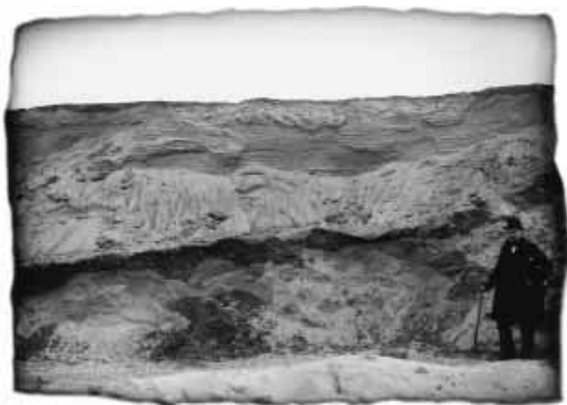
Figur 5. Billedet er taget i 1896 under arbejdet med udvidelsen af jernbanegennemskæringen i Valby bakke. I begge sider af billedet ses moræneler og i den midterste del af billedet ses et legeme af smeltvandssand. På skrå i sandet ses et lag moræneler der følger lagdelingen i sandet. Dette moræneler blev aflejret som en slamstrøm i det bassin hvor smeltvandsstrømmen aflejrte sandet. Lejringsforhold og sedimenterne (i profilet og i de mange borer) kan tolkes på den måde at bakken var et bassin i isen under afsmeltningen.
